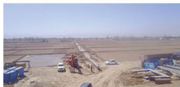
黄河天然气穿越项目
